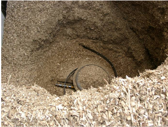
Abbildung 43: Schneckenaustrag mit Blattfederrührwerk (Quelle: HDG-BAVARIA)
