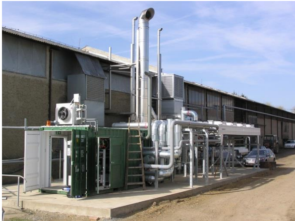
Abbildung 56: ORC-System (mit R245fa) einer tschechischen Biogasanlage (Quelle: GE Energy)
