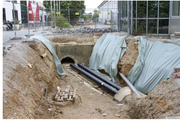
Abbildung 19: Bau eines Fernwärmenetzes in Deutschland (Quelle: Rutz)
