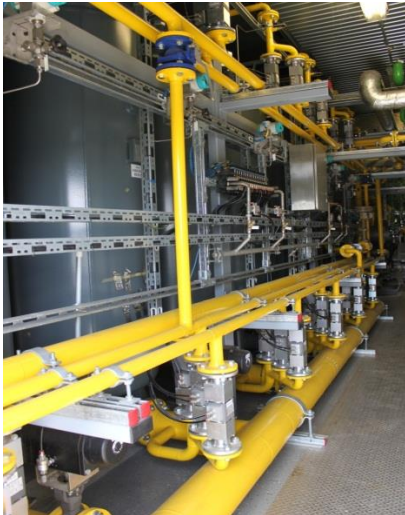
Abbildung 66: Druckwechsel-Adsorptionstechnologie (PSA) in Aiterhofen, Deutschland (Quelle: Rutz)
