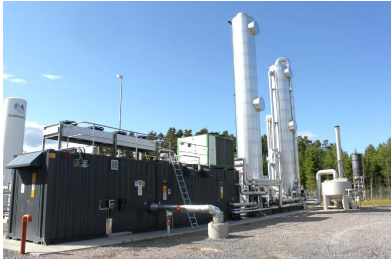
Abbildung 67: Druckwasserwäsche in einer Aufbereitungsanlage der Firma Swedish Biogas International in Lidköping, Schweden (Quelle: Rutz)
