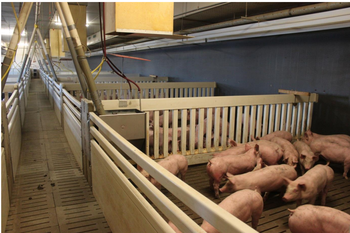
Abbildung 26: Zeitgemäß belüfteter Schweinestall in Deutschland, welcher mit Abwärme der Biogasanlage beheizt wird (Quelle: Rutz)
