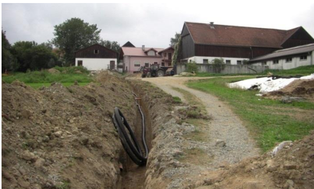
Abbildung 12: Verlegung einer Wärmeleitung zu den Gebäuden eines landwirtschaftlichen Betriebes (Quelle: Thermaflex Isolierprodukte GmbH)
