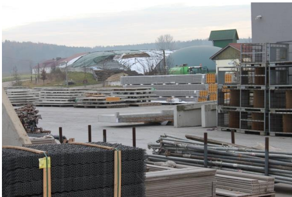
Abbildung 34: Wärme von einer Biogasanlage (Hintergrund) in Deutschland, welche Wärme zur Betonfertigteilproduktion liefert (im Vordergrund) (Quelle: Rutz)
